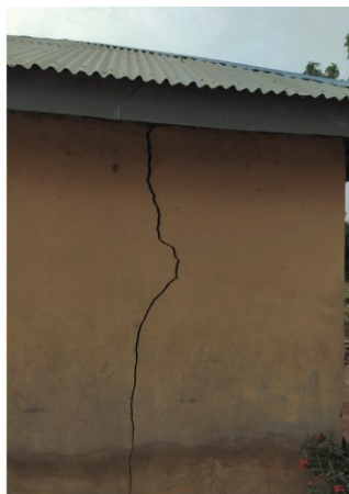
Ein Riss an der Außenmauer und in der Mauer über dem Fenster.
