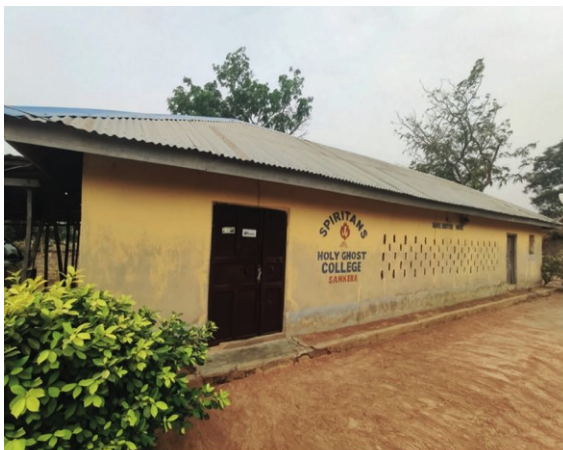
Dieses Haus wurde 2005 mit lokalen Blöcken gebaut und steht kurz vor dem Einsturz.
