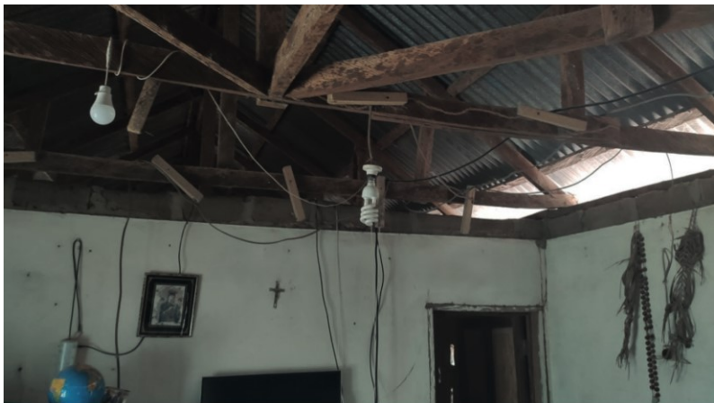
Das Zimmer von Pater Kuha. Die Decke wurde von Termiten gefressen.
