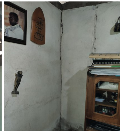
Ein Riss an der Wand im Wohnzimmer.
