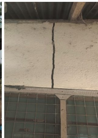
Ein Riss an der Außenmauer und in der Mauer über dem Fenster.
